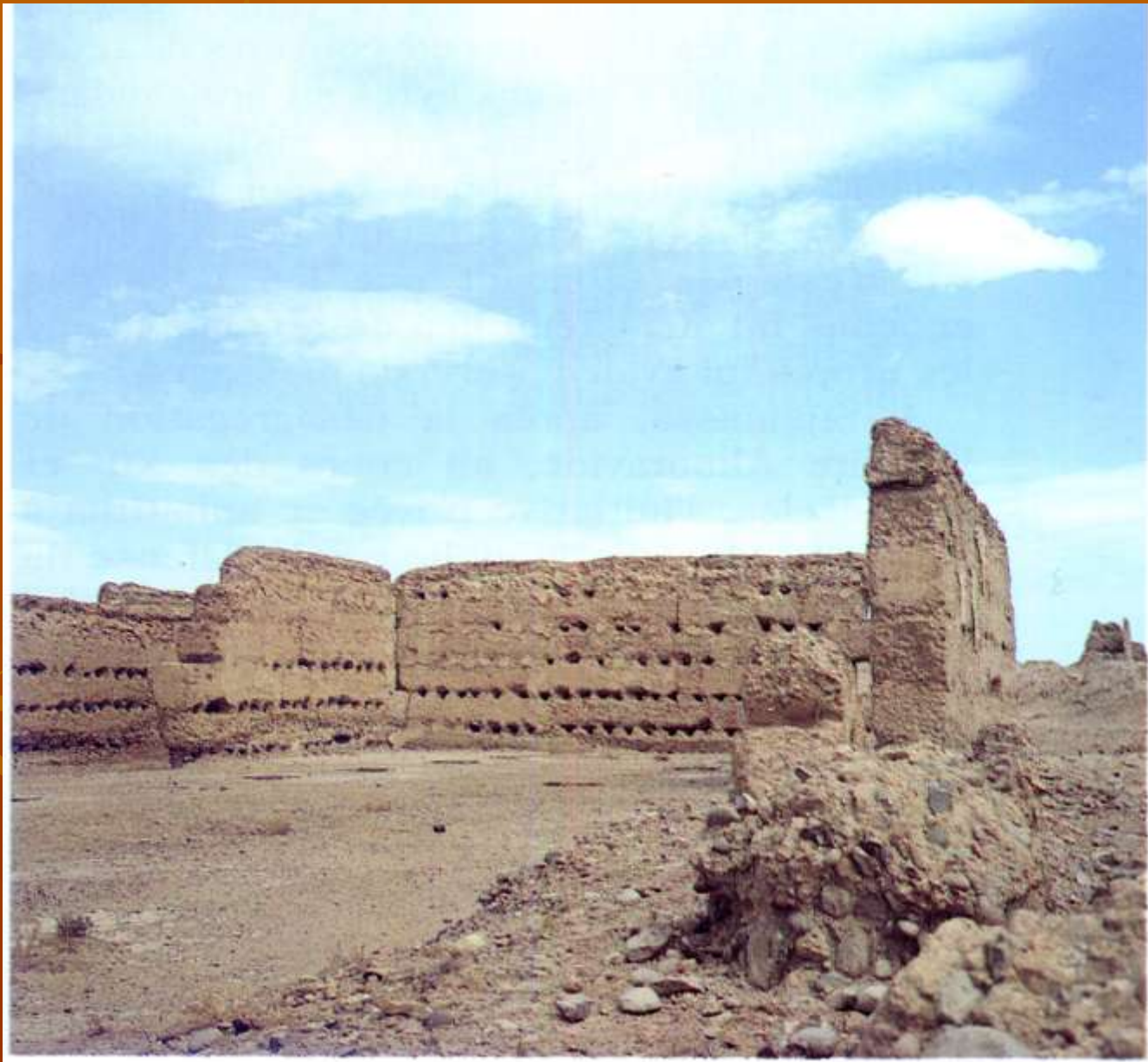
Ruines de Sijilmassa
